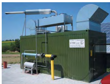
Bloc cogenerare în container – compact, izolație fonică și instalare rapidă
